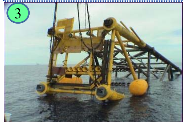
ติดตั้งโครงสร้างส่วนขา
