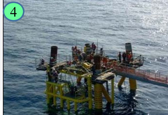
ติดตั้งโครงสร้างส่วนบน
