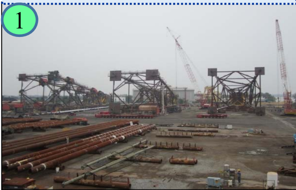
ประกอบโครงสร้างของแท่นหลุมผลิตบนฝั่ง
