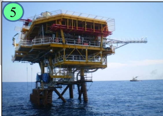
ตัวอย่างแท่นหลุมผลิตที่ติดตั้งแล้วเสร็จ
